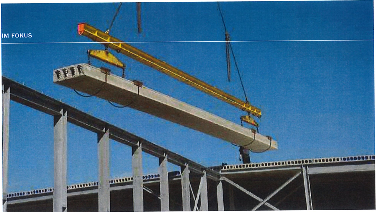
515 Stellplätze, 14 Splitlevel, 7 Geschosse: Die DW Systembau verbaute über 12.800 qm Hohlkammerdeckenplatten mit 40 cm Stärke und rund 824 qm Deckenplatten mit 26 cm Stärke.
